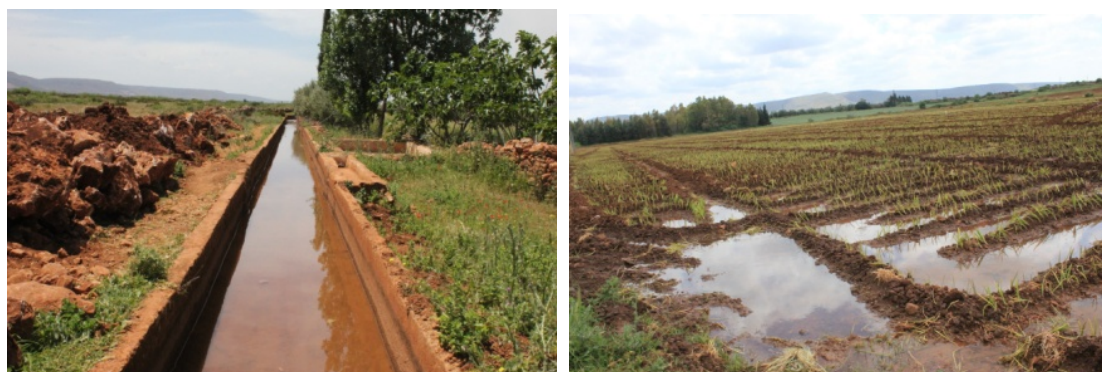
Photo 1. Canal du périmètre irrigué et irrigation en gravitaire dans la zone de Bittit
