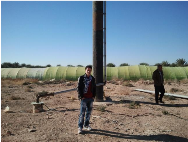
Figure 3a. Dispositif de château d'eau en amont du réseau d'irrigation
