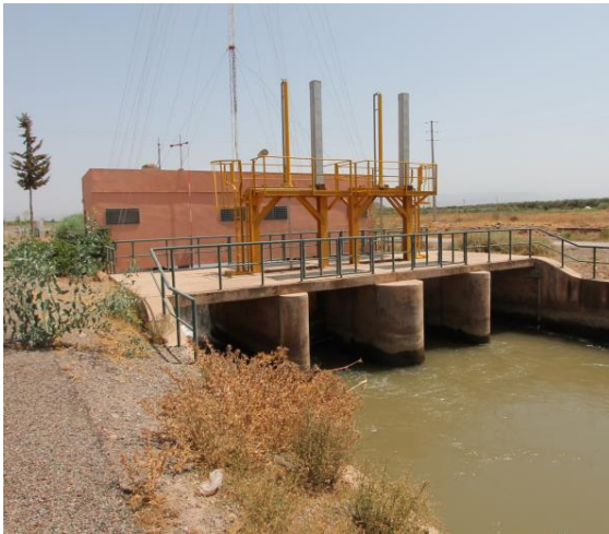
Photo 1. Vannes motorisées sur le canal de Rocade
