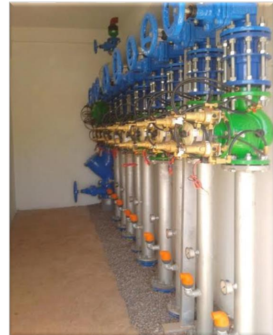
Photos : Prise-borne au niveau d'un bloc d'irrigation et les compteurs à l'intérieur de la prise-borne
