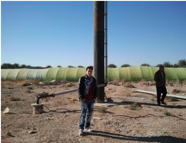
Figure 3a. Dispositif de château d'eau en amont du réseau d'irrigation
