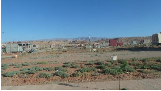
Photographie 3. Lotissement en construction. Bd Mohamed V, Tinghir (Smith 2023)
