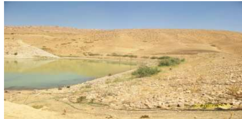
Photo : retenue collinaire, Saneg, Médéa, 201
